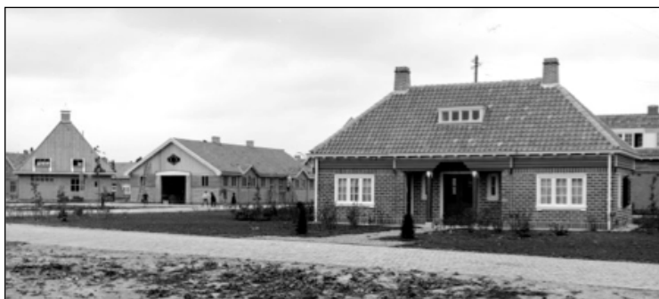
1918: Badhuis, brandweerkazerne en administratiegebouw Vogeldorp. (Bron: Beeldbank Amsterdam)
