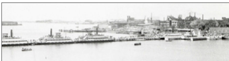
1945 pontenbrug Buiksloot. (foto: beeldbank Amsterdam)
